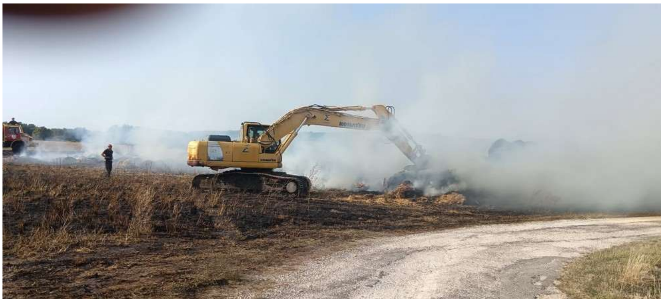
Pelle mécanique venue en renfort
